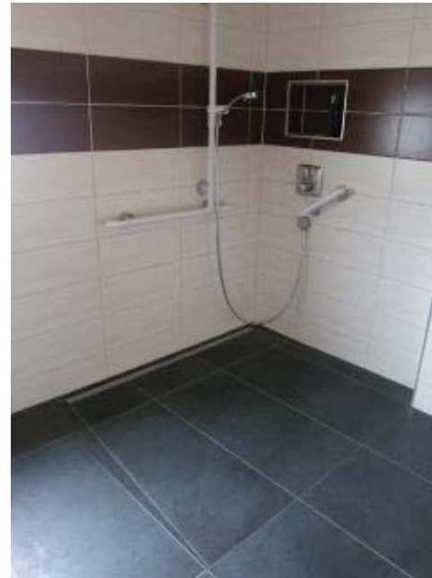
Bad mit R-Anforderung
